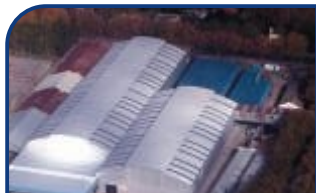
Techos de chapas
